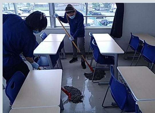
2F第1教室薬剤塗布塗り込み
